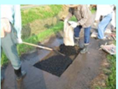
農道の部分補修
