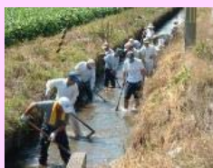
水路の泥上げ
