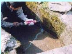
水路のひび割れ補修
