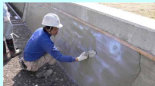
老朽化した水路壁のコーティング
