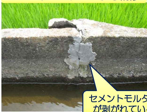
セメントモルタルによる補修
