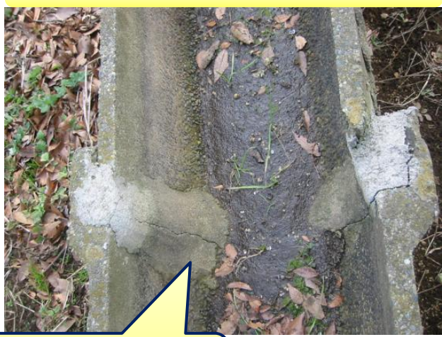
セメントモルタルによる補修
