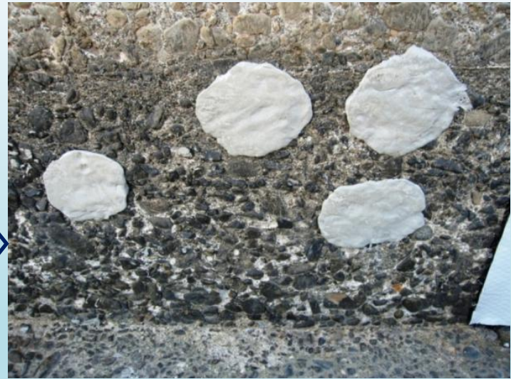
水中パテ施工後
