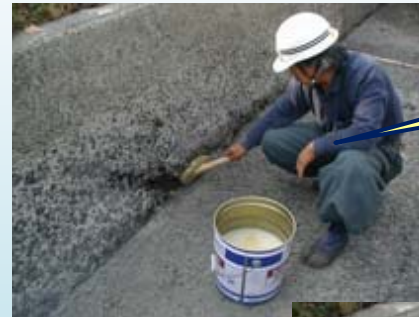
プライマー塗布
