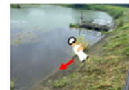
(ため池堤体の急傾斜)
