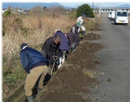
◇ 水路の泥上げ
