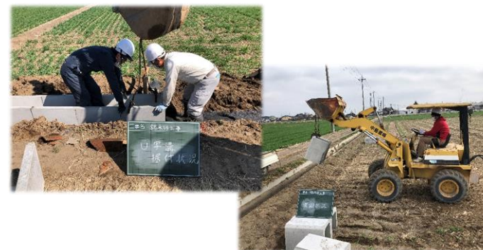
◇ コンクリート水路への更新
