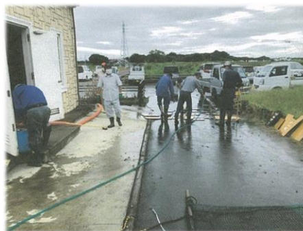
◇ ポンプ場管理作業状況
