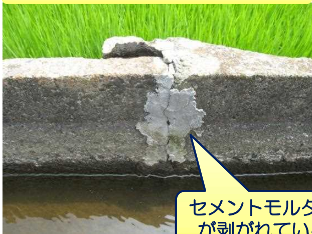
セメントモルタルによる補修
