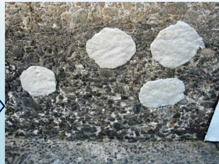
水中パテ施工後
