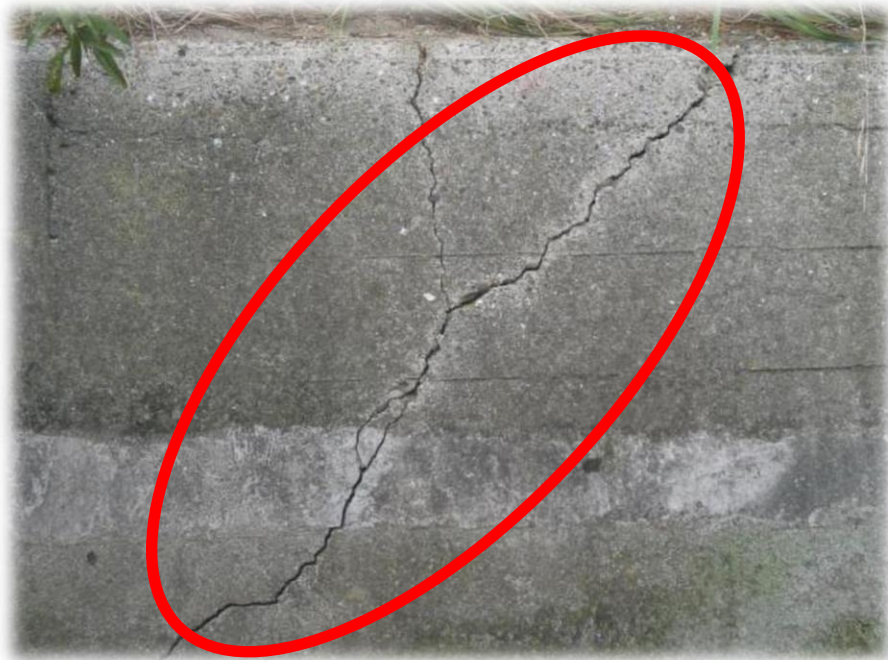
斜めに走るひび割れ (地滑りなどの大きな力をうけたもの)
