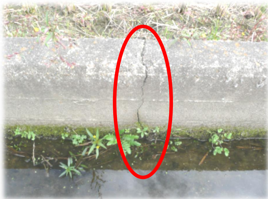
縦方向のひび割れ (目地と目地の中間付近に見られる)
