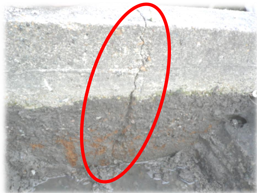
ひび割れから水田への漏水 (逆に水田から水路に漏水することもある)
