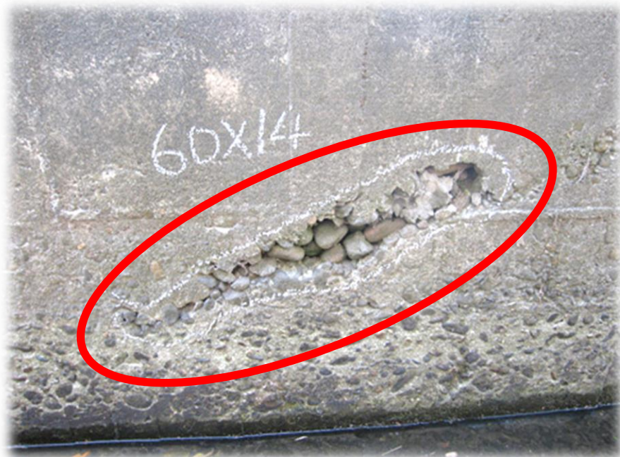
局所的な骨材露出 (ジャンカ)
