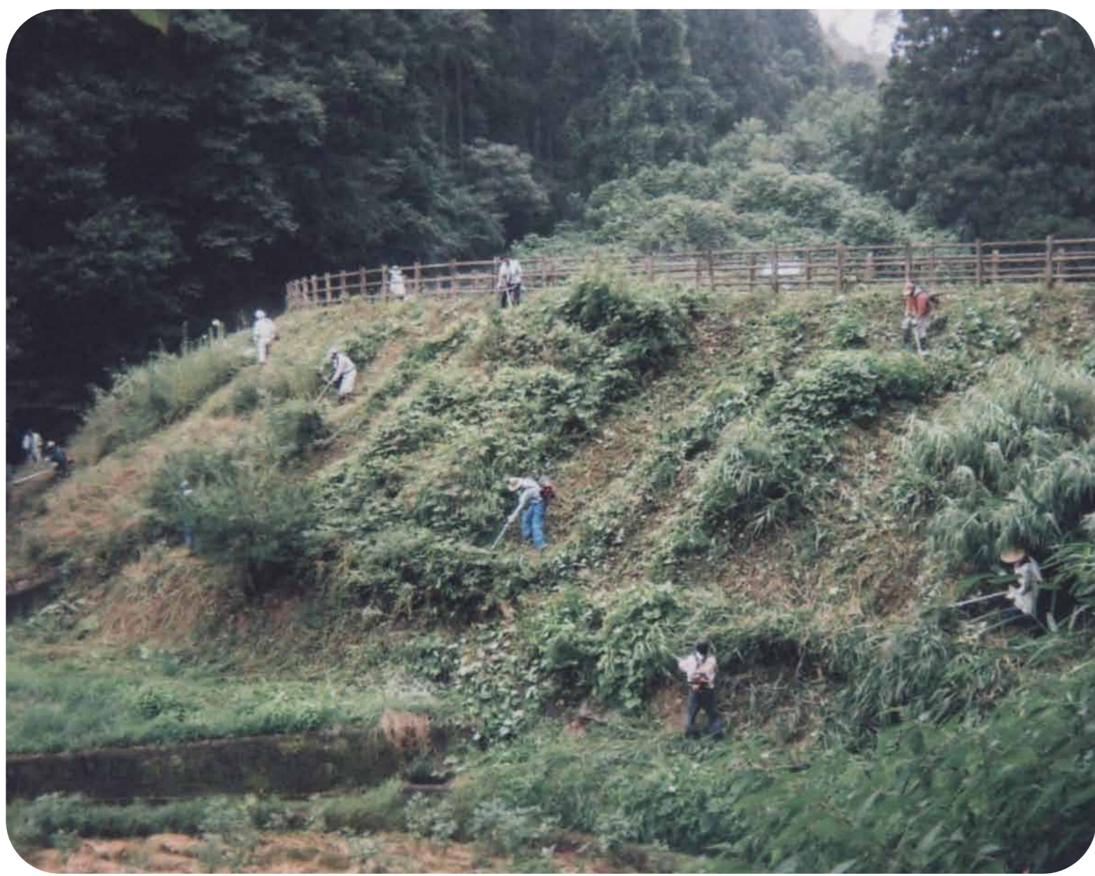
ため池法面の草刈り
