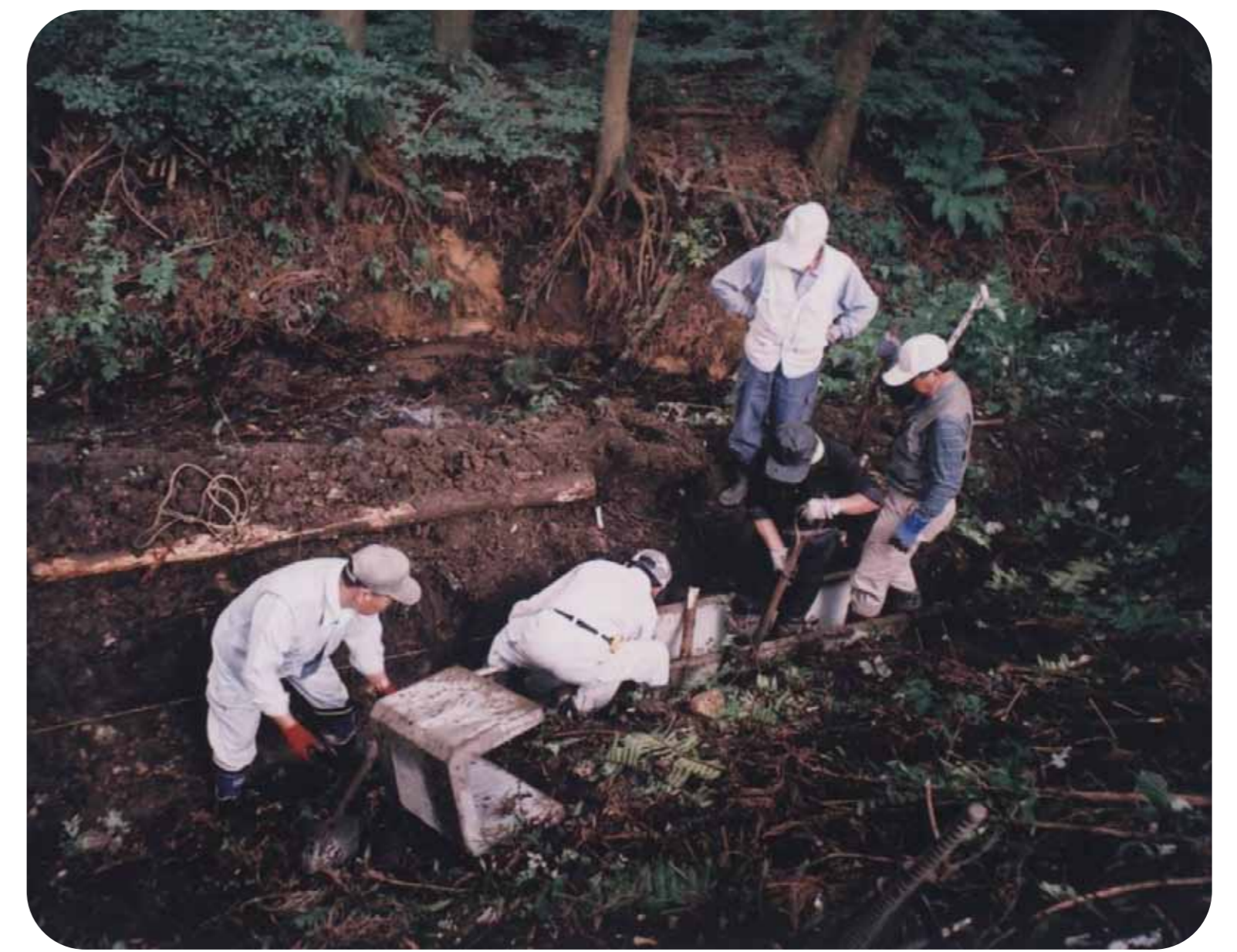
水路の布設替え
