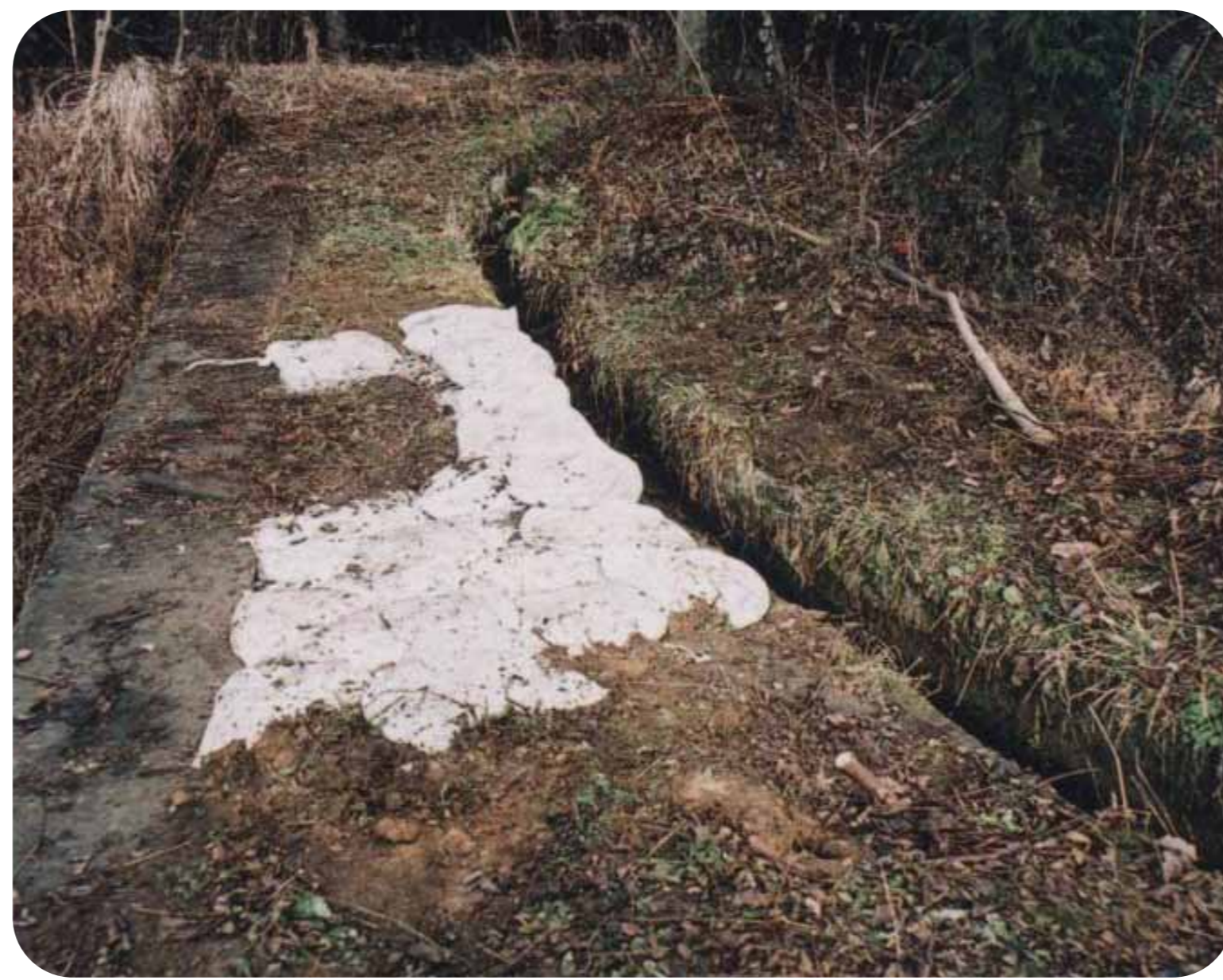
手づくり土嚢による水路の補修
