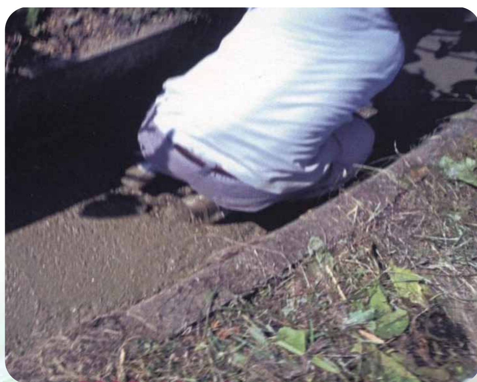
農業用水路のコンクリート補修
