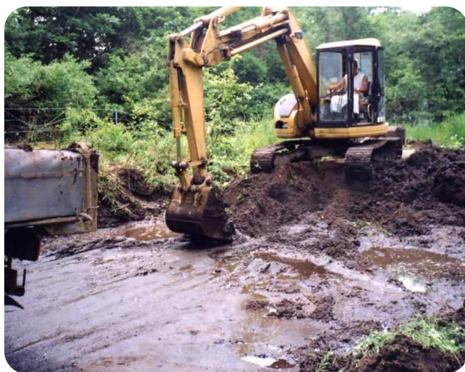
沈砂池の浚渫
