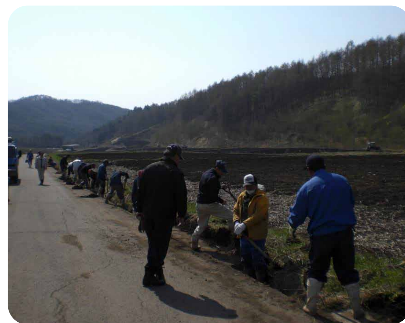
農道側溝の泥上げ
