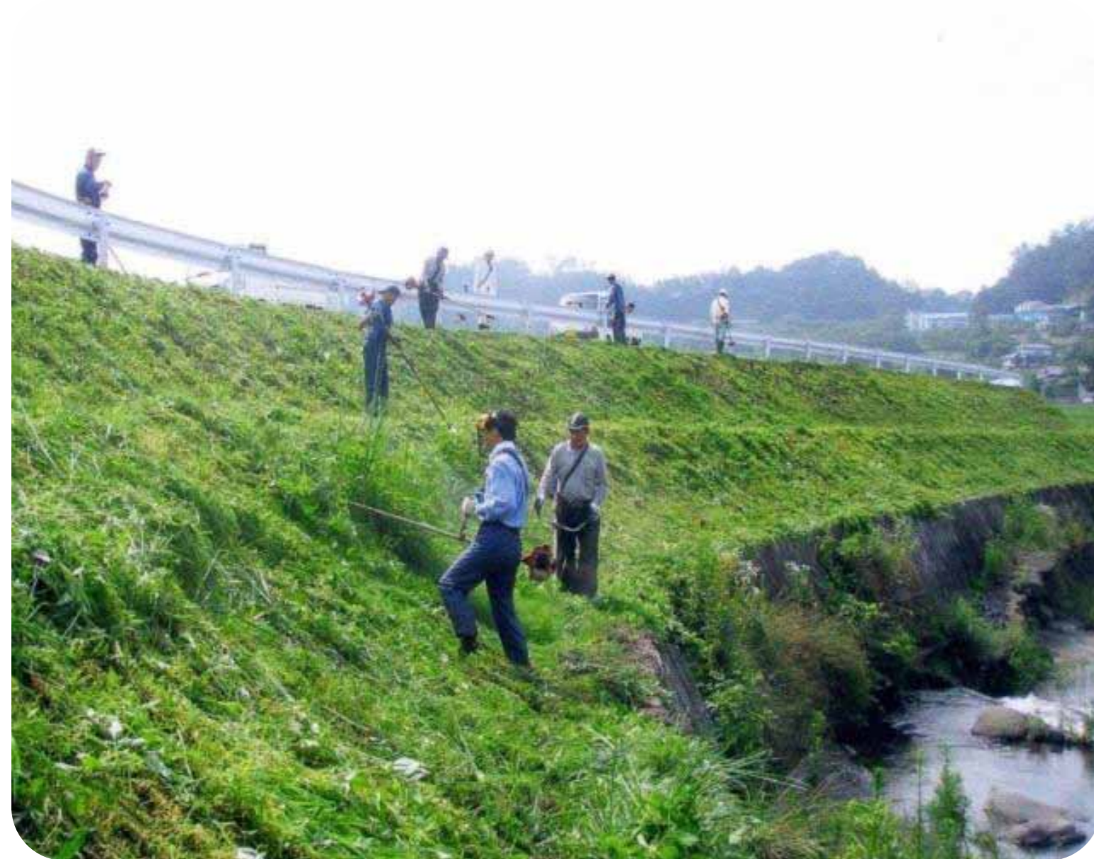
道路法面の草刈り
