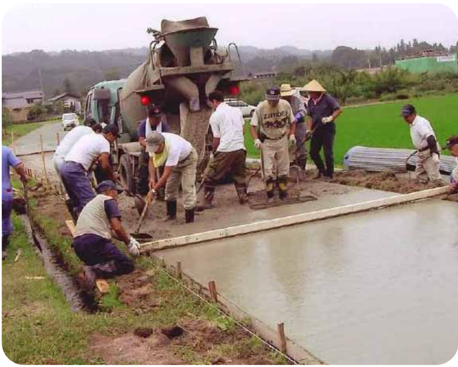
農道のコンクリート舗装
