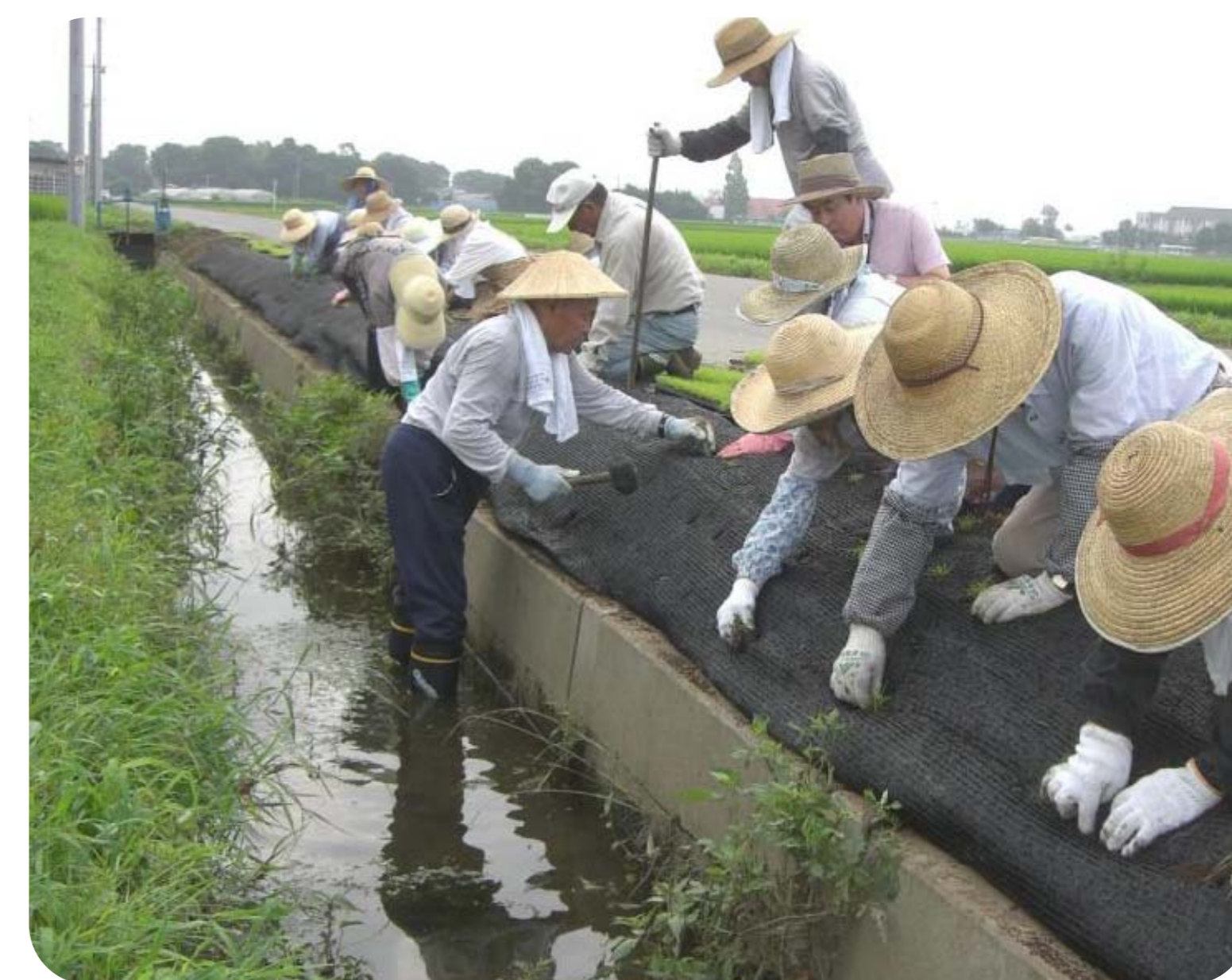
水路法面に防草シートを設置
