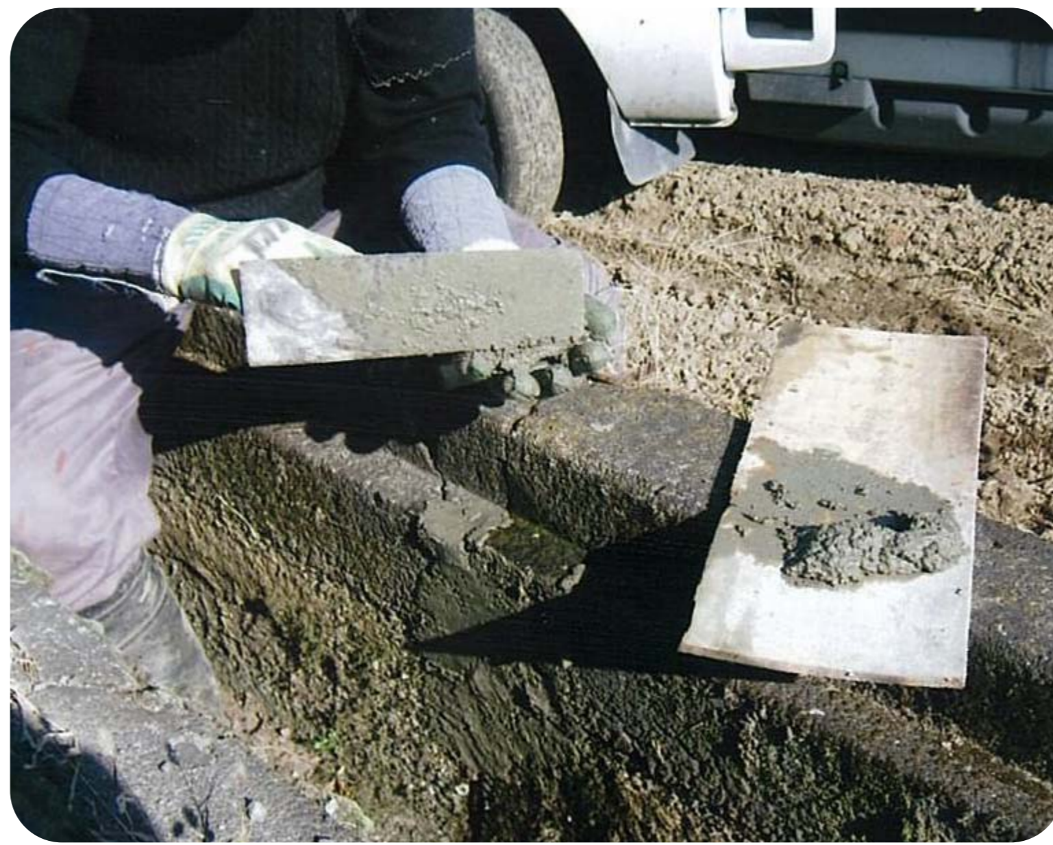
水路の目地補修作業
