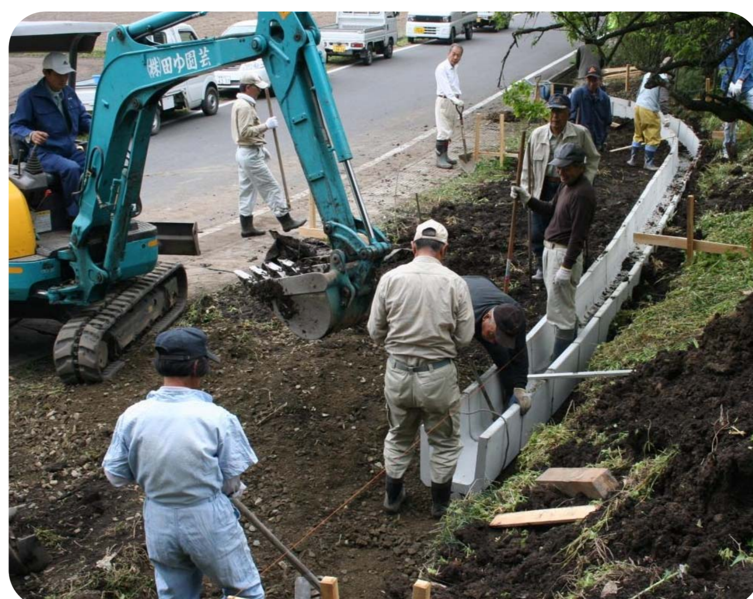
コンクリート水路の敷設作業
