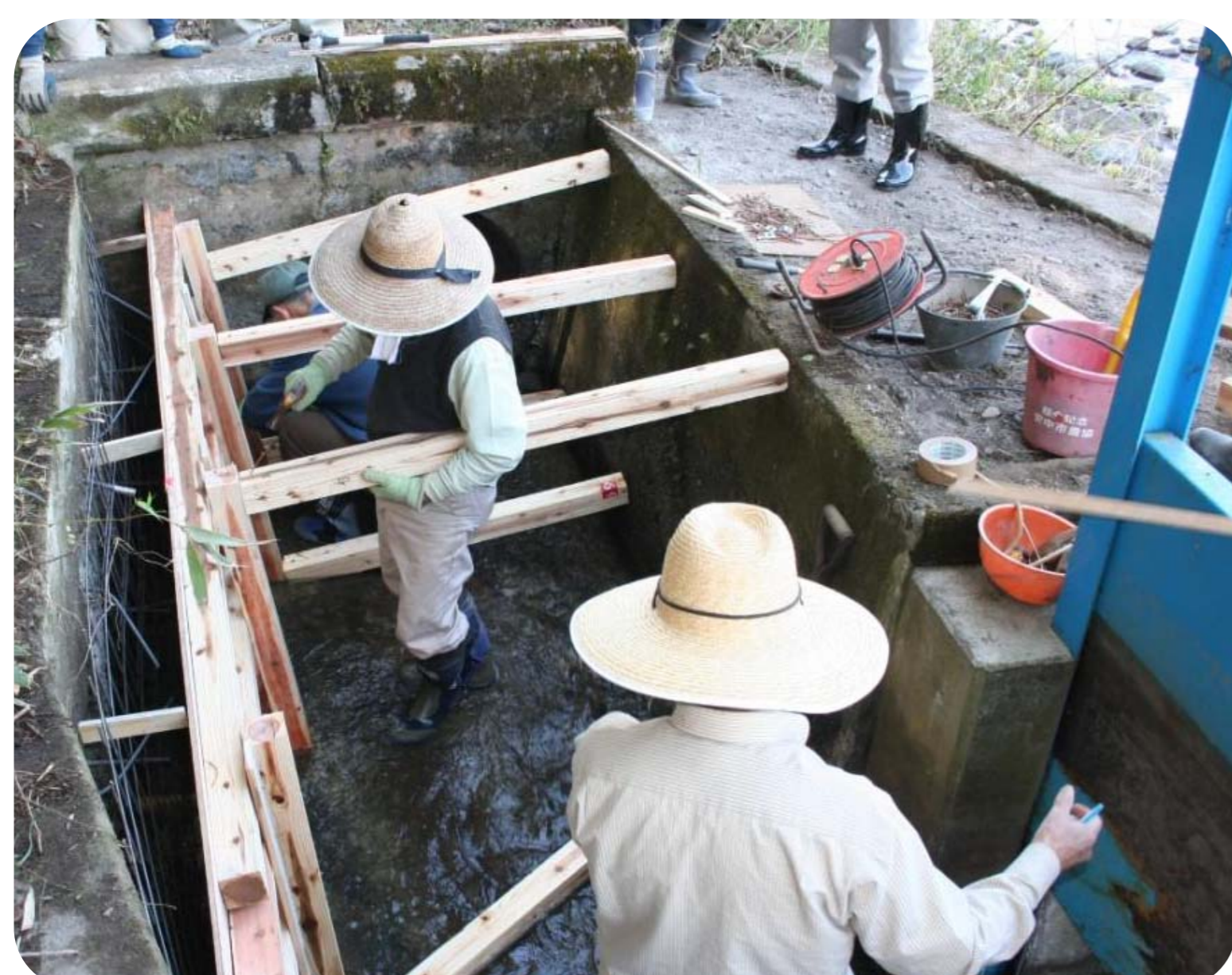
地域住民による水路補修のための型枠設置
