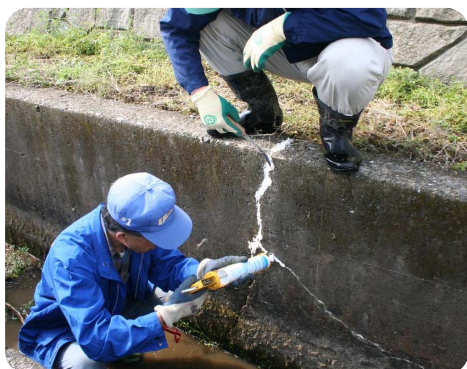
水路の目地補修
