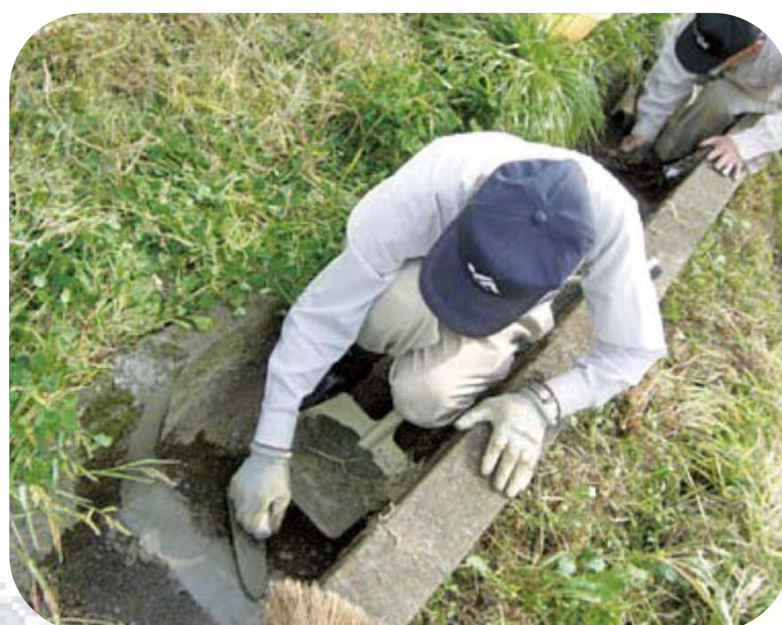
モルタルで水路目地の補修
